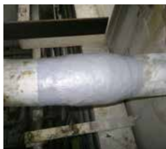
Frettage et réparation par plaques
